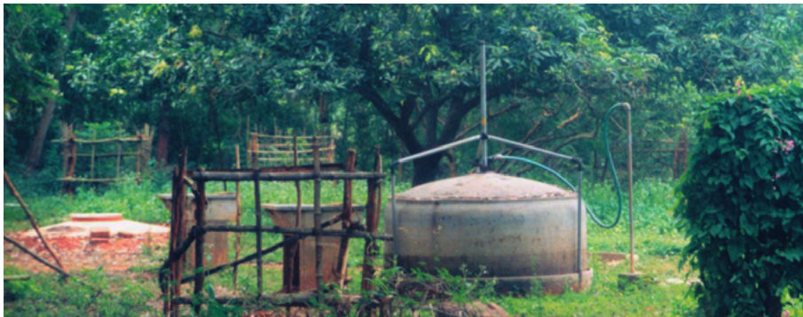
Ferrozement-Biogasanlage zum Kochen in Hildes Küche 1995
